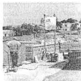
TRANI Lavori a Capo Colonna
