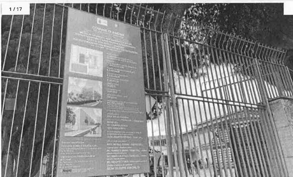
Parte oggi il crono programma dei lavori di demolizione e ricostruzione della scuola Jannuzzi
