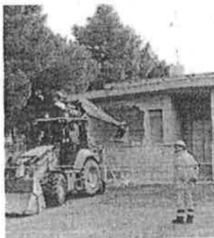
I LAVORI Lo ruspa davanti alla scuola
