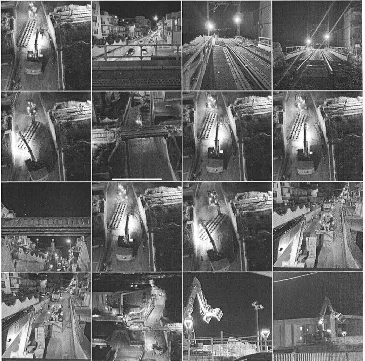
Lavori di interrimento ferroviario di Andria, rimozione del ponte di via Bisceglie
