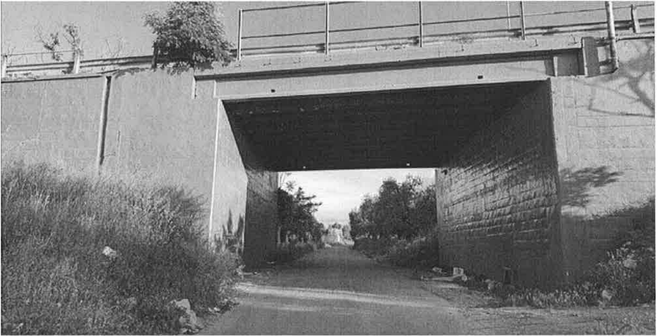
Ponte di via Sgarantiello © AndriaLive
