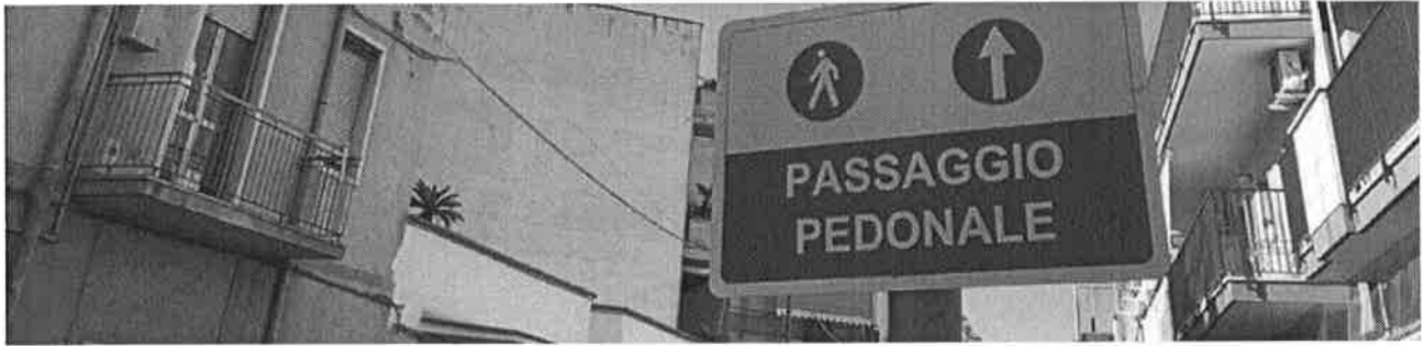
Cantiere interramento ferroviario in via Ospedaletto © AndriaLive
