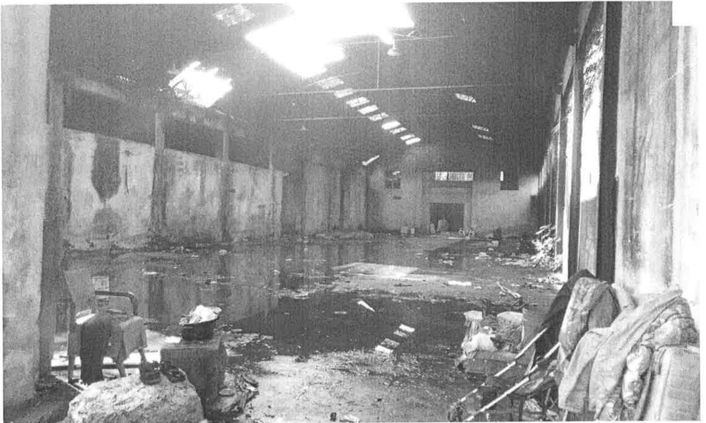
Capannone abbandonato (foto Legambiente Andria)
