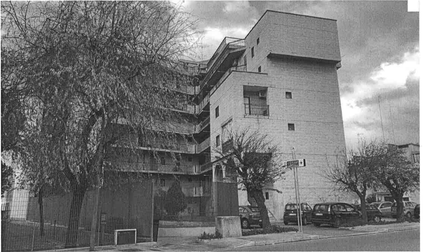
Edifici in viale Virgilio
