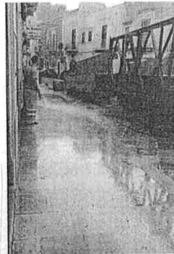
ANDRIA Ecco il ponte Bailey "provvisorio" in via Carmine
