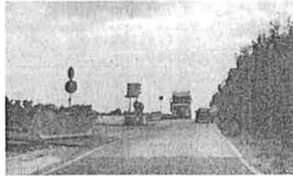
PERICOLI La attuale deviazione mette a rischio la circolazione a causa delle dimensioni ridotte e delle condizioni delle strade complanari
