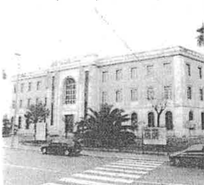
LA SEDE CENTRALE Il liceo «De Sanctis»
