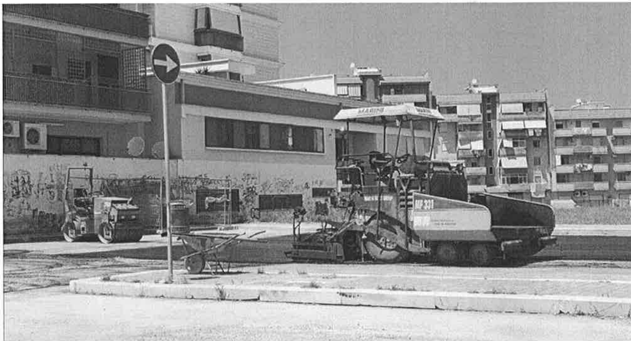
Lavori bitumazione largo Ceruti/AndriaMultiservice © AndriaLive
