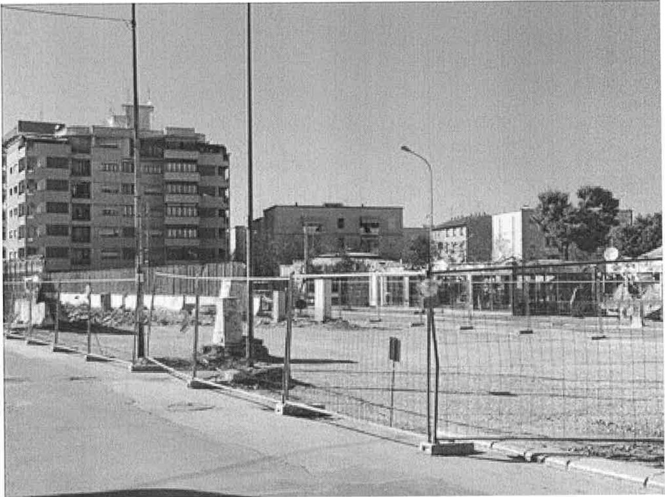
Interramento ferroviario, operazioni di apertura del varco di via XXIV maggio © AndriaLive
