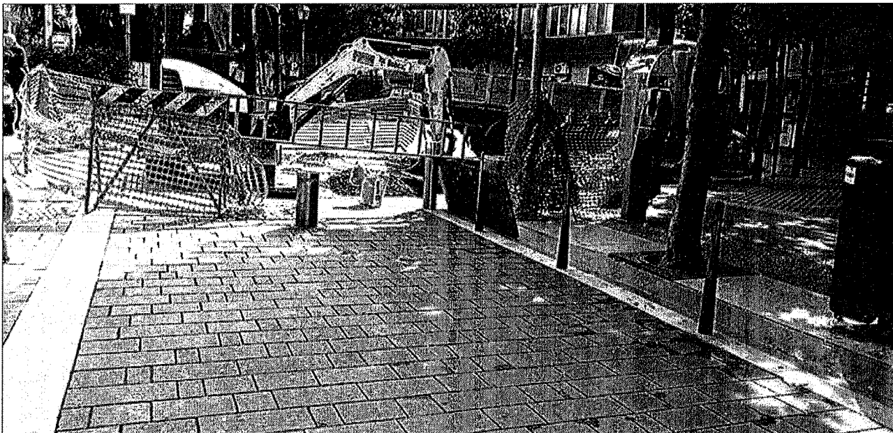
lavori in corso in viale Crispi per la realizzazione della fontanina pubblica © AndriaLive
