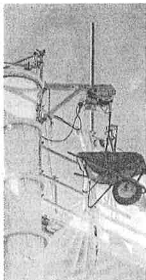
SUPERBONUS Un cantiere
