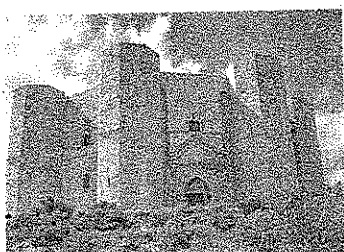
VISITA Castel del Monte
