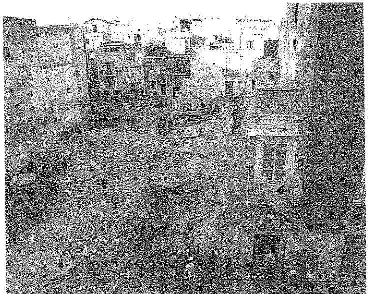
COME UNA BOMBA Dopo il crollo dell'edificio in via Roma [foto Calvaresi]
