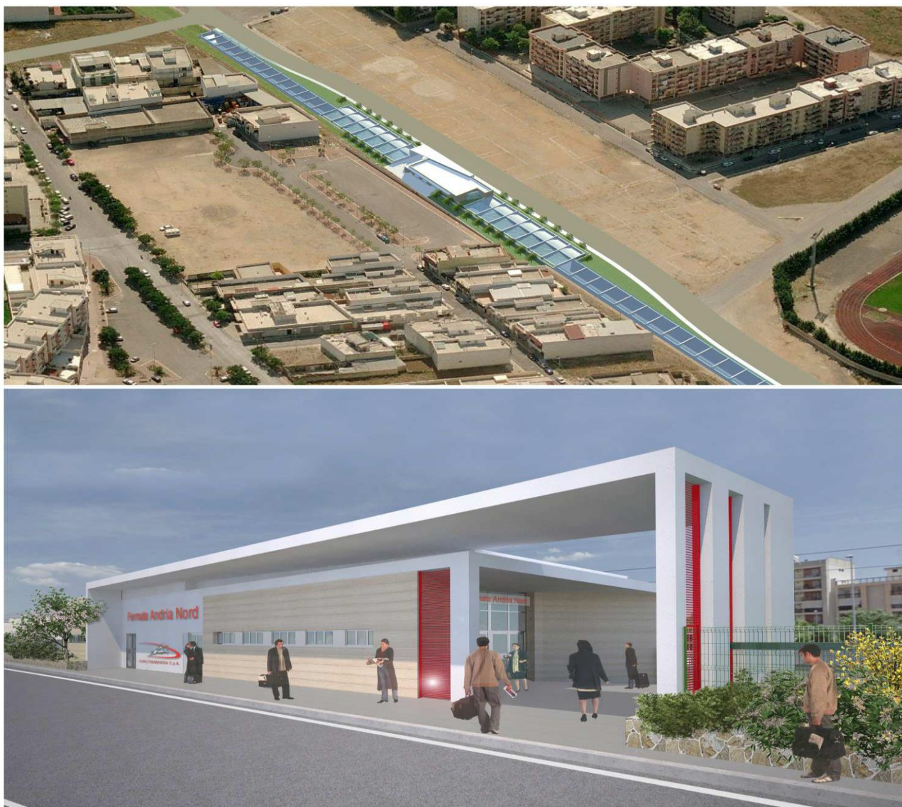
Figura 4.7 – Viste della stazione Andria Nord
