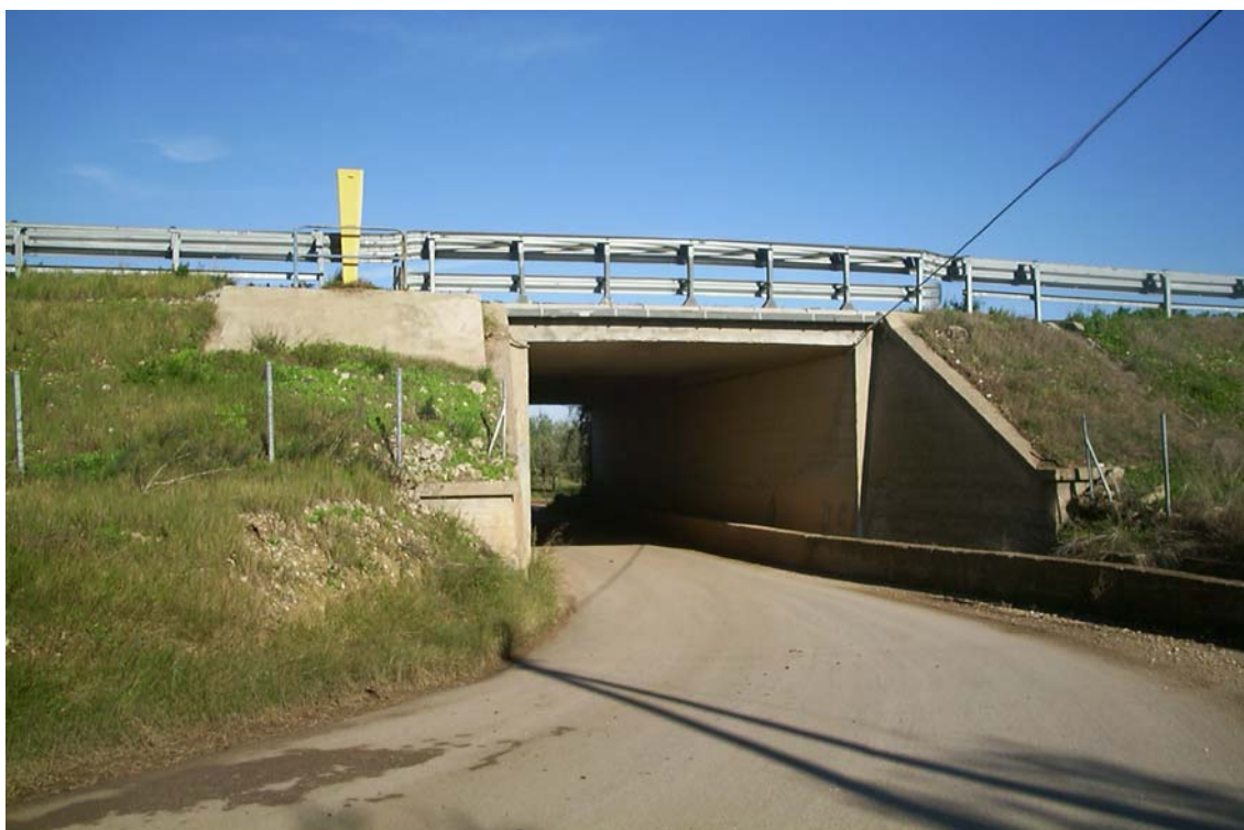
L'autostrada A14 in corrispondenza di strada Monachelle
