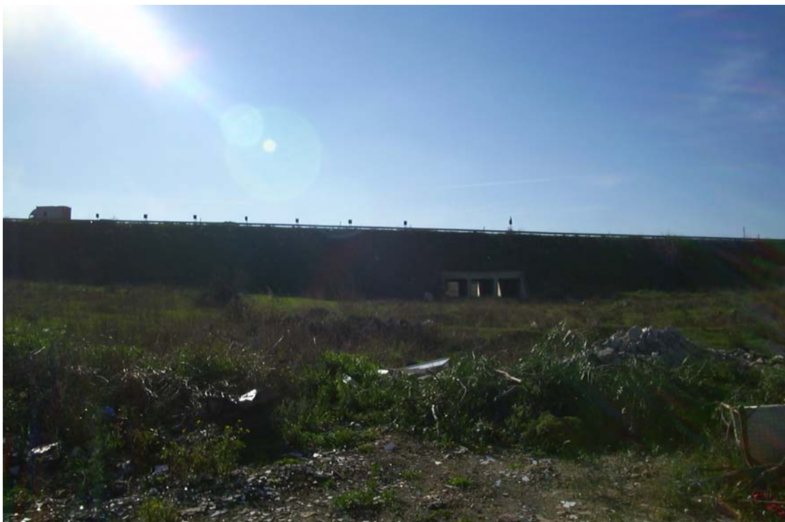
La depressione naturale a valle della tangenziale
